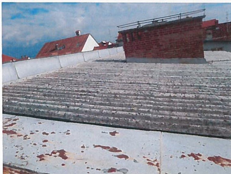
Slika 17: Poškodbe strehe na severovzhodnem dvonadstropnem prizidku: poškodovane pločevinaste strešne obrobe – korozija, dotrajana strešna kritina (najverjetneje azbestno-cementna kritina), lokalne poškodbe na betonskem zaključku dimnika – razpadanje betona in korozija armature
