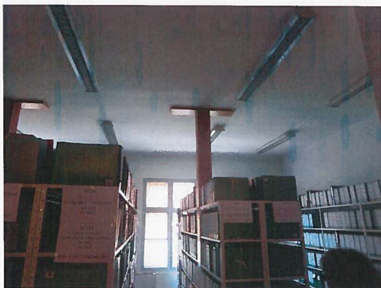
Slika 13: Leseni stebri v območju arhiva; ni razvidno ali gre za morebitno podpiranje stropne konstrukcije ali morda za stabilizacijo knjižnih regalov
