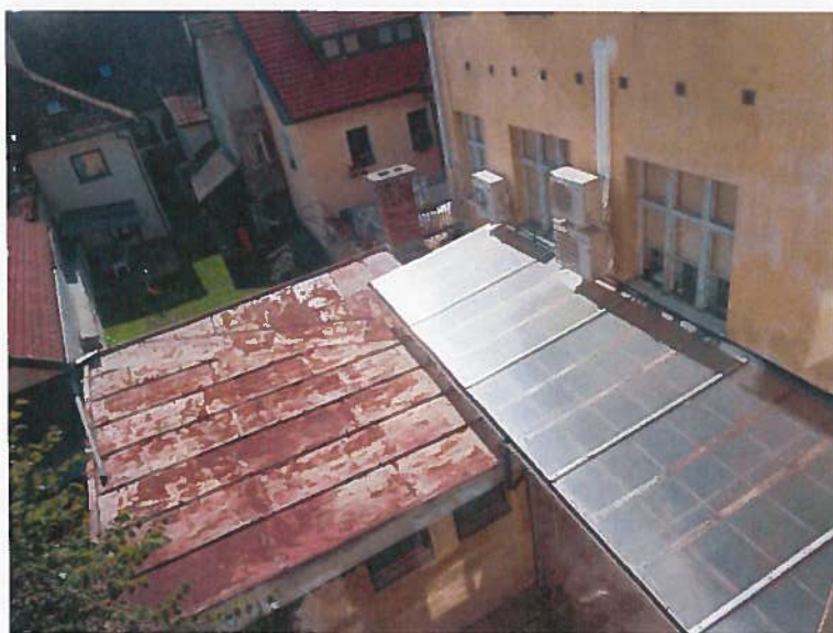
Slika 18: Poškodbe strehe na jugovzhodnem pritličnem prizidku: korozija pločevinaste kritine
