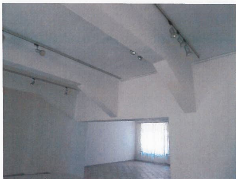
Slika 12: Vidna betonska zasnova stropne konstrukcije v pritličju osnovnega dela objekta
