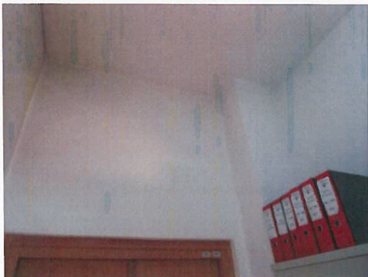
Slika 22: Poškodbe v notranjosti: poševne razpoke v območju preklade nad vrati
