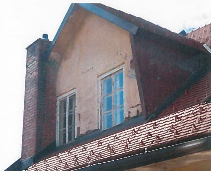
Slika 20: Poškodbe na fasadi: močno razpadanje ometa in luščenje opleska v območju frčad osnovnega objekta
