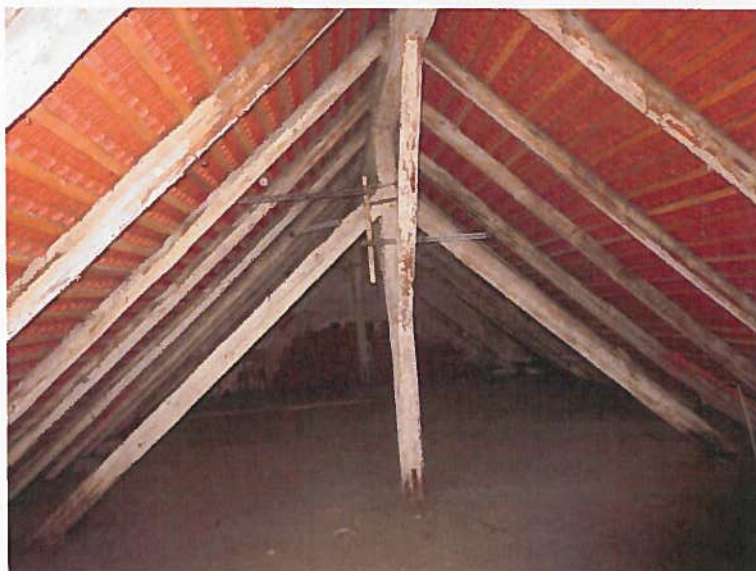
Slika 8: Zasnova ostrešja v območju osrednjega dela objekta; lokalno dotrajani elementi ostrešja, zamenjana strešna kritina
