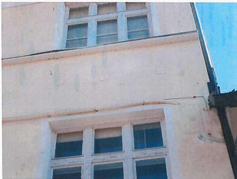
Slika 7: Zračniki na fasadi kažejo na prisotnost lesenih stropov
