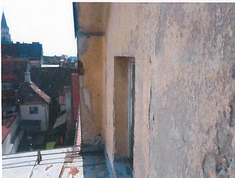
Slika 19: Poškodbe na fasadi: močno razpadanje ometa in luščenje opleska v območju napušča in zatrepne stene
