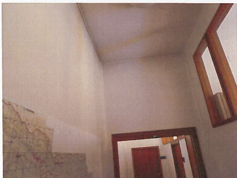
Slika 23: Poškodbe v notranjosti: poševne razpoke v območju preklade nad vrati
