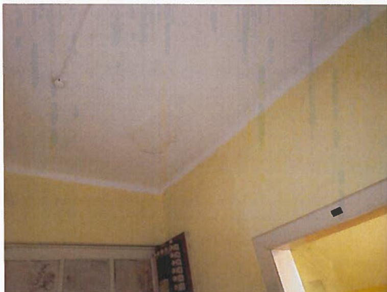
Slika 25: Poškodbe v notranjosti: lokalno luščenje opleska na stropu v območju mansarde
