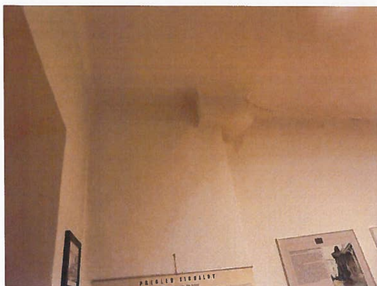
Slika 30: Poškodbe v notranjosti: razpoke na zidu in na stropu; geometrija konstrukcije kaže na verjetno prisotnost armiranobetonskih elementov
