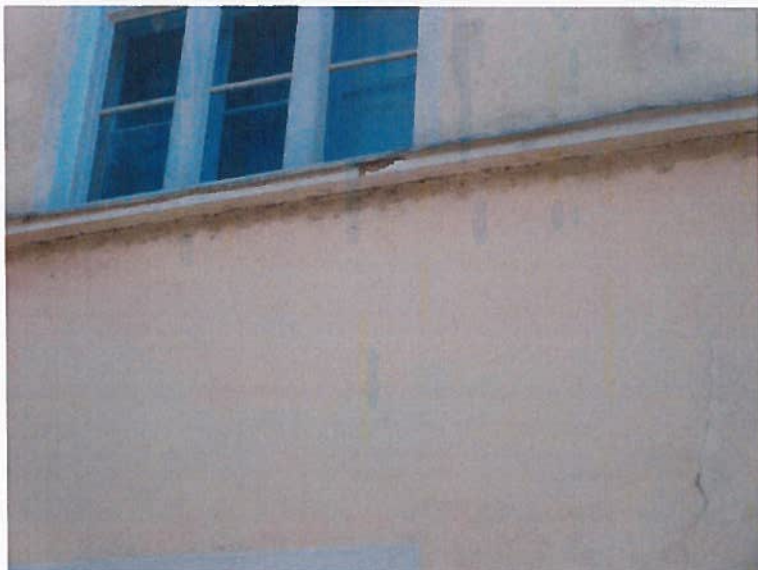
Slika 16: Poškodbe na fasadi: vertikalna razpoka na zidu v območju nad vratno odprtino, luščenje opleska na zidnem vencu
