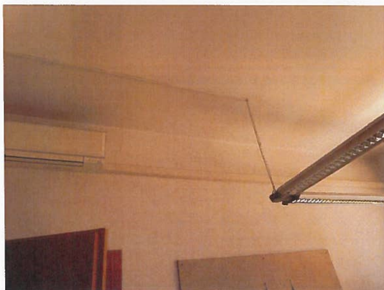
Slika 24: Poškodbe v notranjosti: mrežaste razpoke v ometu
