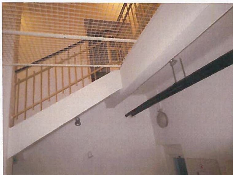
Slika 11: Vidna betonska zasnova konstrukcije stopnišča
