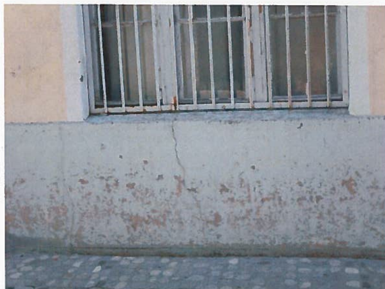
Slika 14: Poškodbe na fasadi: razpoke na zidu v območju cokla, luščenje opleska
