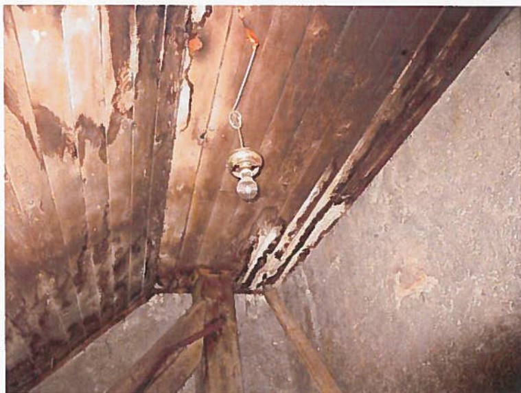
Slika 28: Poškodbe v notranjosti: vidni sledovi preteklega zamakanja strehe na opažu in elementih ostrešja v mansardi
