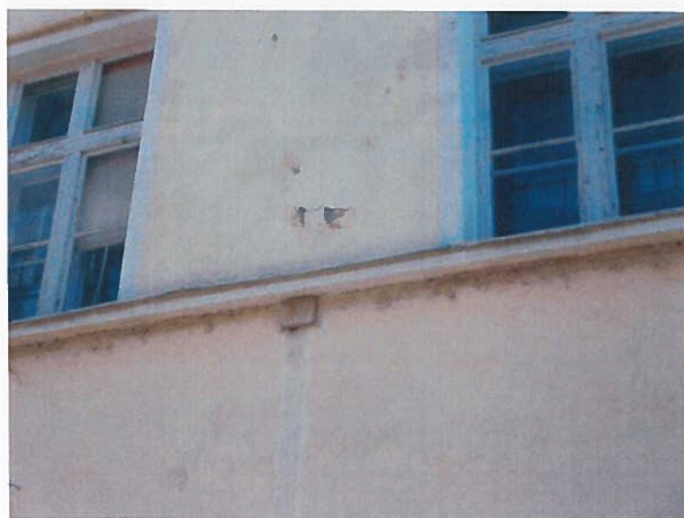
Slika 15: Poškodbe na fasadi: razpadanje ometa in luščenje opleska
