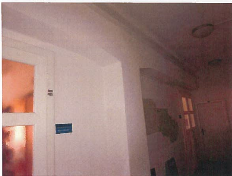
Slika 9: Geometrija elementov kaže na armiranobetonsko zasnovno nosilne konstrukcije – steber z vutasto razširjenim nosilcem
