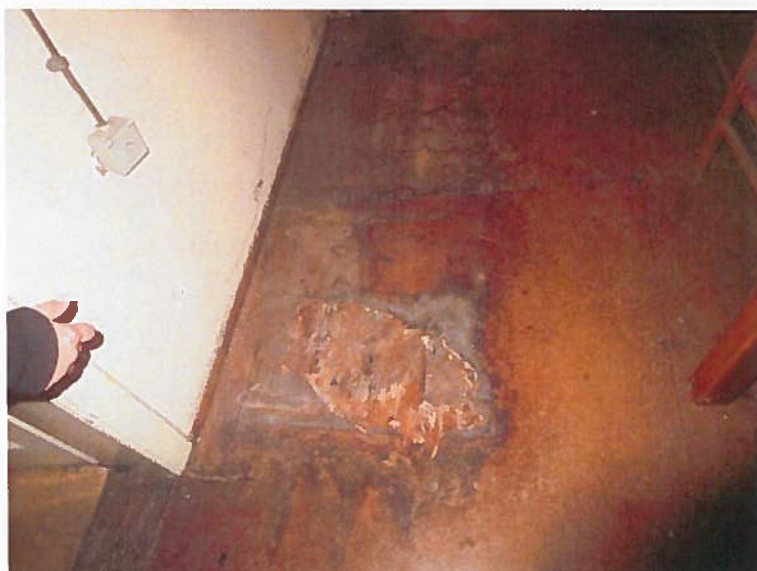
Slika 26: Poškodbe v notranjosti: lokalne poškodbe v tlaku, najverjetneje kot posledica preteklega zamakanja; vidni leseni elementi stropne konstrukcije
