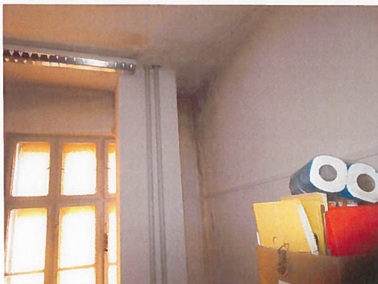
Slika 29: Poškodbe v notranjosti: razpoke na zidu v vogalu in na stropu, vidni sledovi prekomerne vlage;
